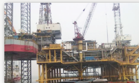
Работы на платформе
