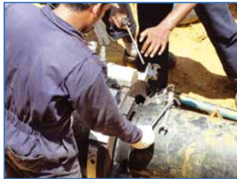
применение трубореза DLW на газопроводах
